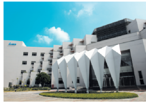
台南研發中心 (鑽石級綠建築)
